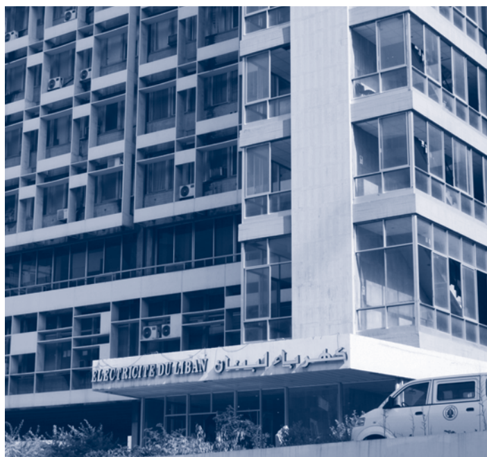
Eléctricité du Liban -Photo by Mohammad Mashlab
